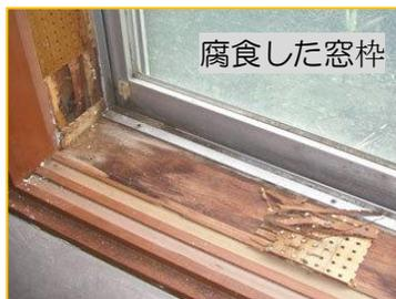
内部まで水分が侵食すると木材、断熱材、柱、やがて建物の土台まで腐食してしまいます。
